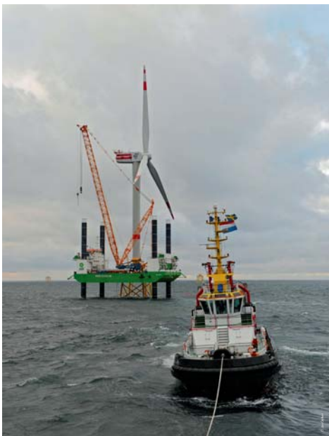
Bauarbeiten im Windpark alpha ventus
