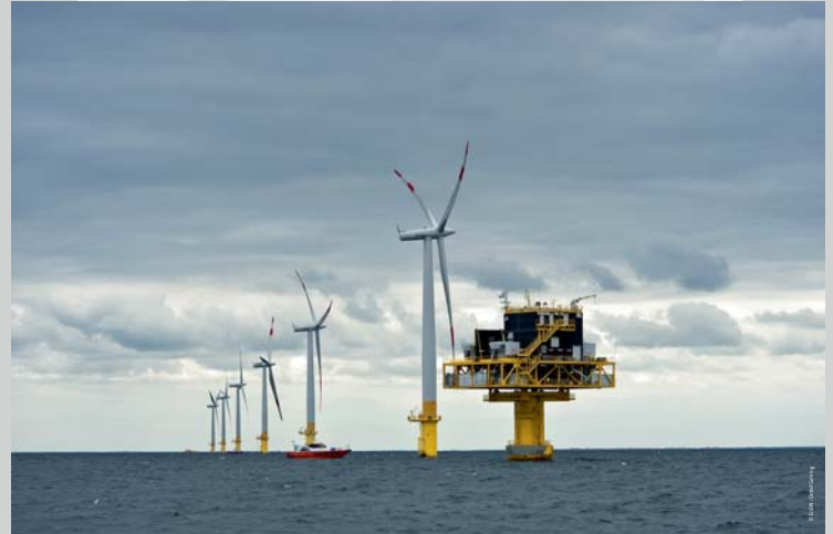
Offshore-Windenergieanlagen mit Umspannplattform bei windertreichem Wetter
