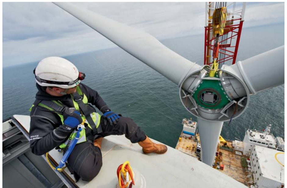
Montage eines Rotorsterns
