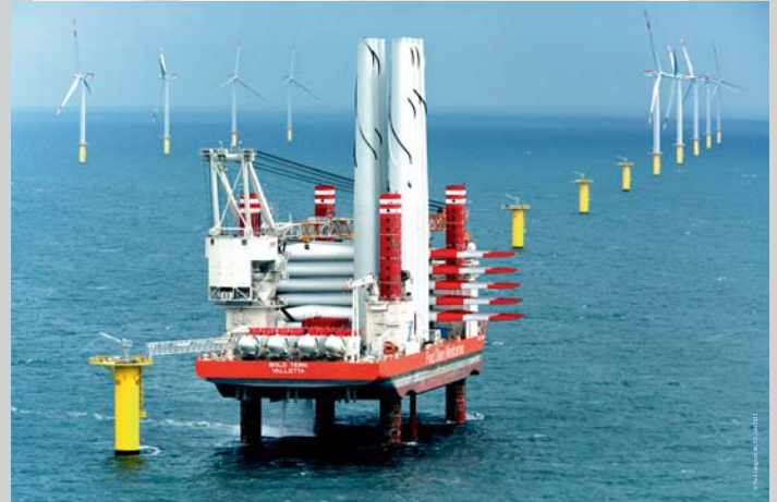
Luftaufnahme Baustelle Offshore Windpark Riffgat
