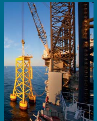
Suction bucket im Windpark Borkum Riffgrund
