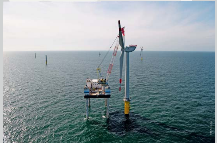
Montage eines Rotorsterns im Windpark „alpha ventus“
