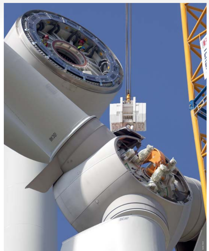
Montage einer Generator-Nabe
