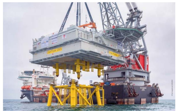
Errichtung Umspannstation auf Jacketfundamentkonstruktion durch Errichterschiff Oleg Strashnov
